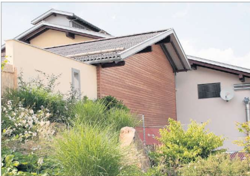
Zur Erweiterung des Saunabereichs wird das bestehende, holzverschaltete Gebäude in der Bildmitte um einen 19 Meter langen Anbau erweitert.
